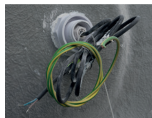
Pool terre installé en dessous du projecteur Pool terre instalado debajo del proyector
